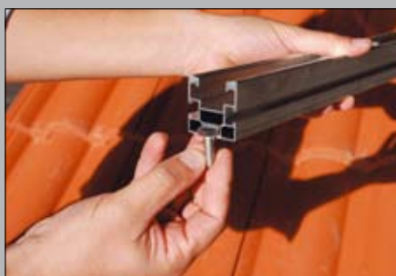
2 - Innesto le viti nel profilo Solar-Plus
