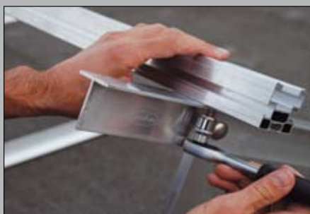
4 - Fisso il profilo Solar-Plus al telaio
