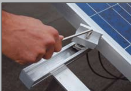
5 - Innesto i morsetti PMF e PMC
