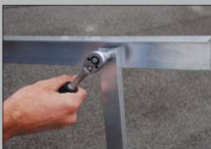
2 - Fisso la posizione del telaio STF
