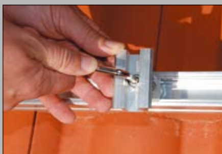
5 - Innesto i morsetti PMF e PMC
